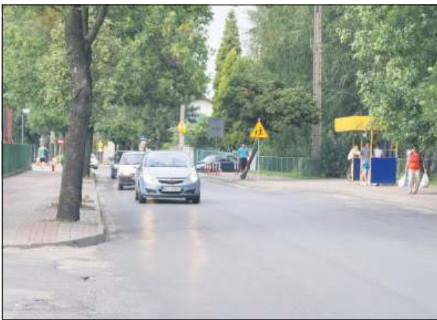
Na pierwszy etap remontu ul. Staszica miasto wyda ponad 1,1 miliona złotych
