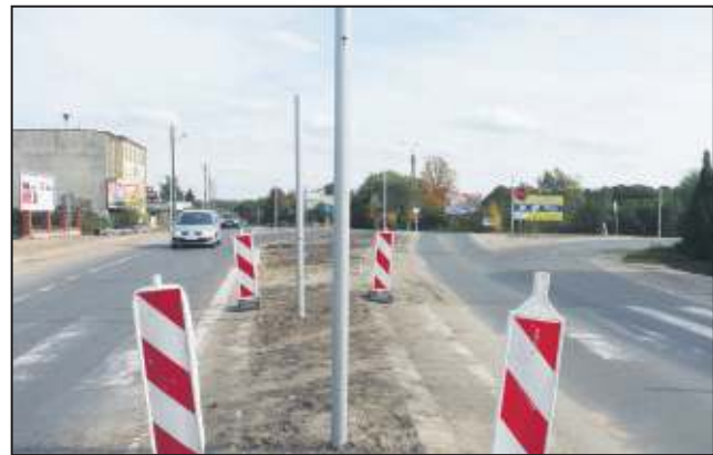
Już niedługo na słupkach pojawi się sygnalizacja świetlna
