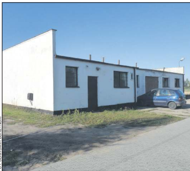
Niewykorzystywana obecnie kotłownia w Rokotowie stanie się budynkiem mieszkalnym
