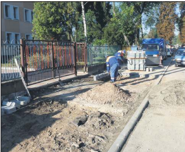
FOT. SŁAWOMIR BURZYŃSKI Niebawem zakończą się prace przy parkingu na ul. H. Sawickiej
