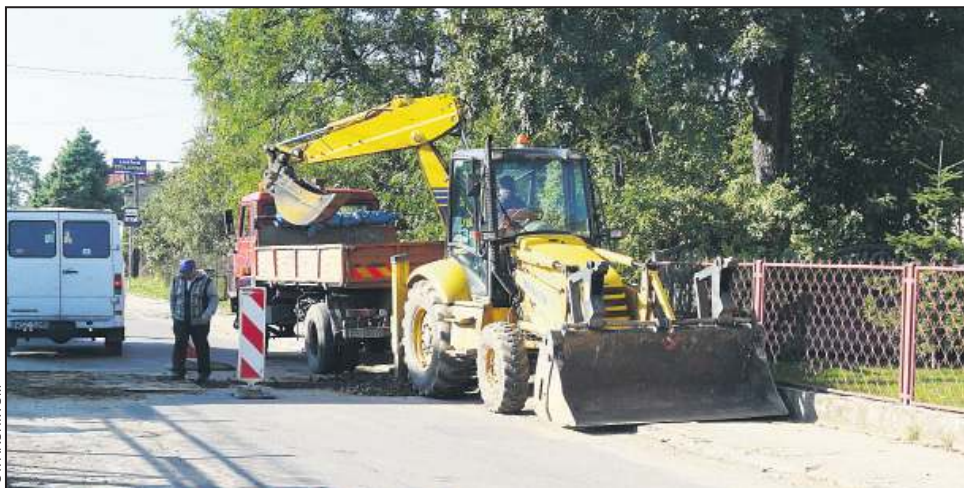
Prace kanalizacyjne na ulicy Rozłazłowskiej
