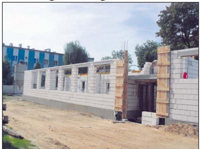
Budynek w stanie surowym ma być gotowy w tym roku
