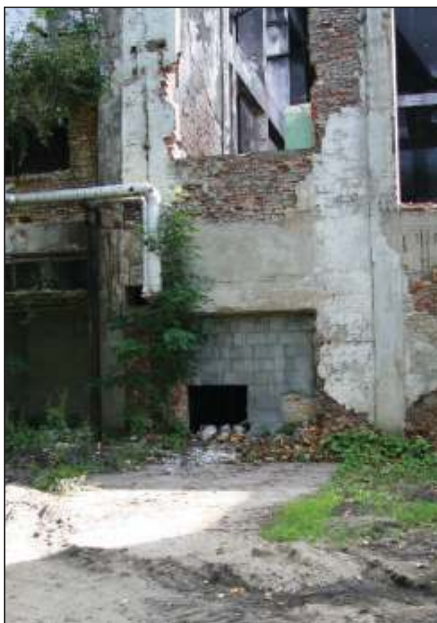
Niebawem na terenie Chemitexu rozebrany zostanie budynek biurowo-laboratoryjny
