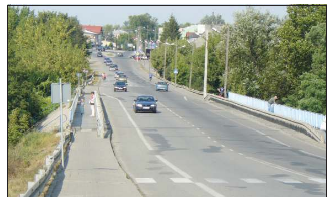
Na przyszły rok planowana jest kompleksowa ekspertyza przeprawy przez Bzurę
