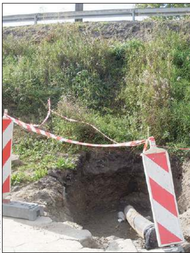
Przecisk to ważny element realizowanej właśnie kanalizacji
