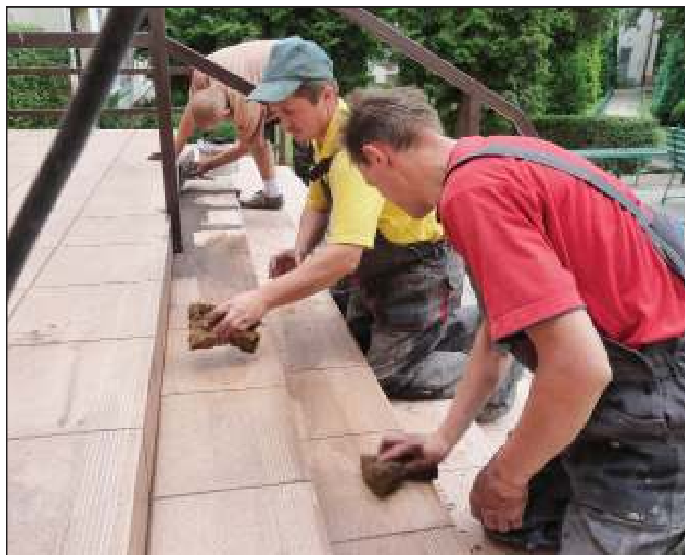
W Szkole Podstawowej nr 3, tuż przed pierwszym dzwonkiem, kończą prace kosmetyczne przy schodach wejściowych
