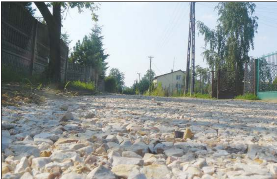
Ulica Popiela zyskała już nową nawierzchnię
