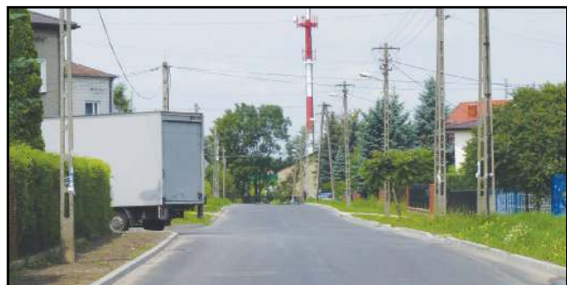
Ulica Okrężna została już utwardzona asfaltem
