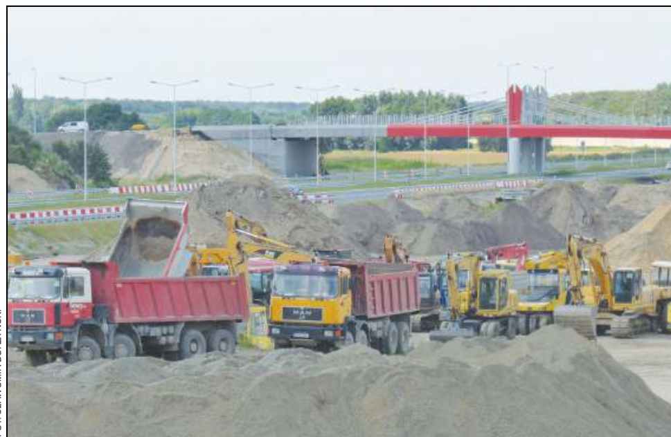
Praca przy zjeździe z autostrady w Wiskitkach idzie pełną parą
