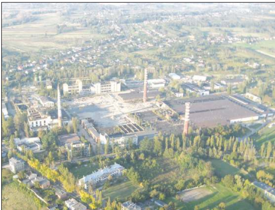
Konsekwencją ustanowienia planu będzie zniknięcie firm śmieciowych z Chodakowa
