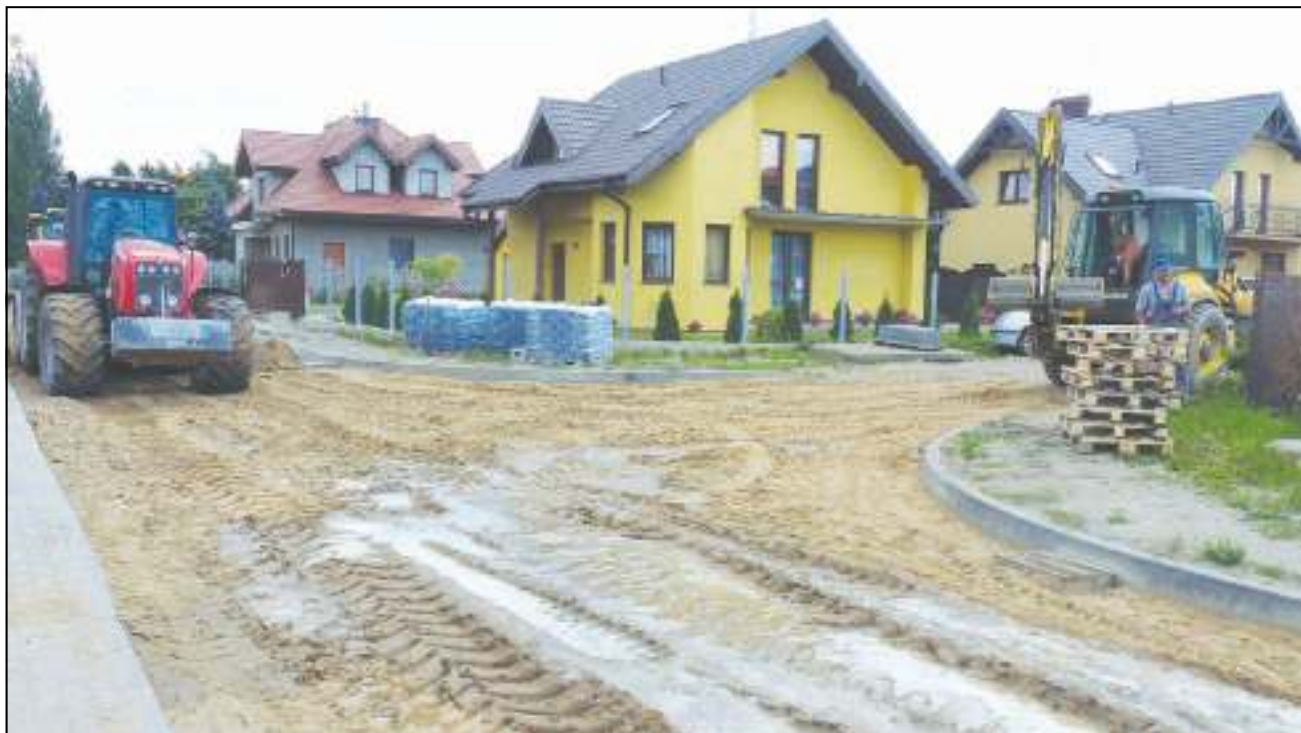
Prace na ulicy Nowowiejskiej wykonuje firma ZWK Józef Siekierski. Po ich zakończeniu w tym miejscu będzie asfalt
