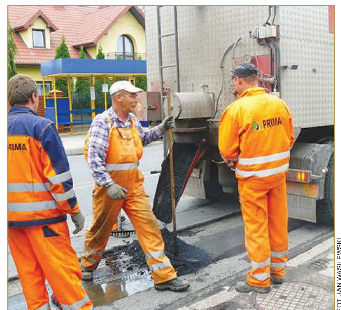
Firma układa nową nakładkę bitumiczną
