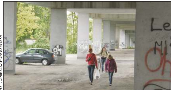
Z przejścia pod wiaduktem korzysta wiele osób
