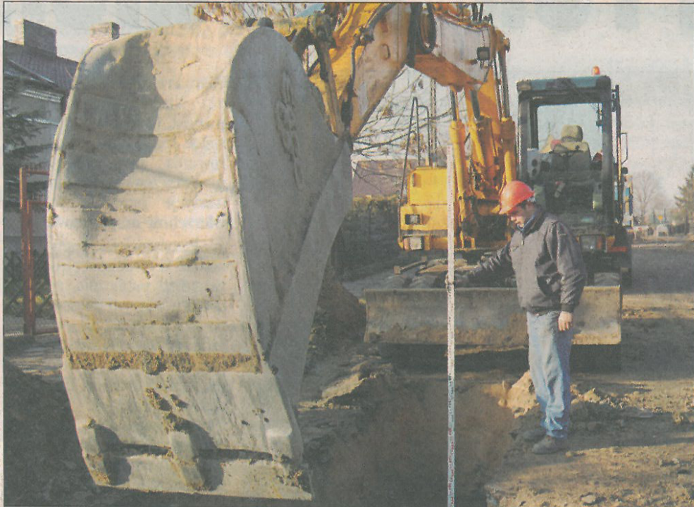
Karol Salaciński z firmy Hydro-Instal sprawdza głębokość wykopu
