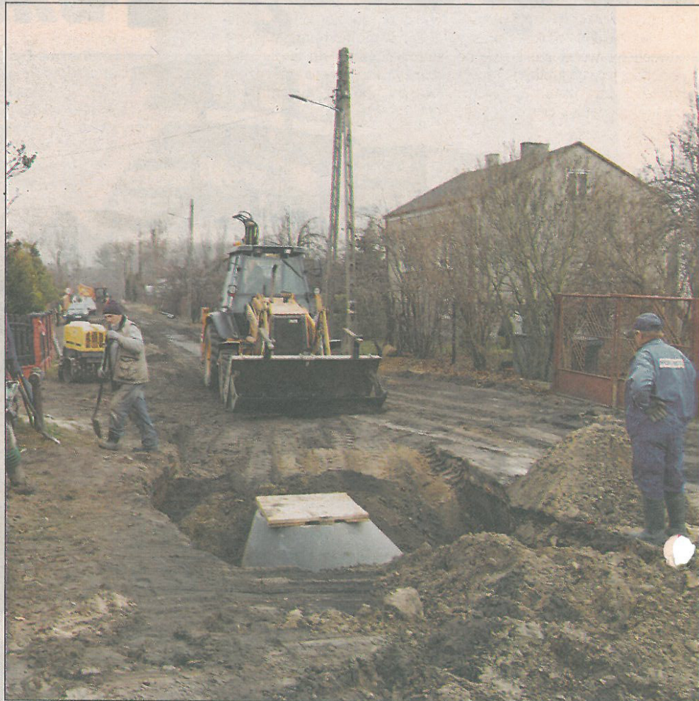
Przeglądaliśmy się pracy ekip kanalizacyjnych przy ulicy Zieleńczej
