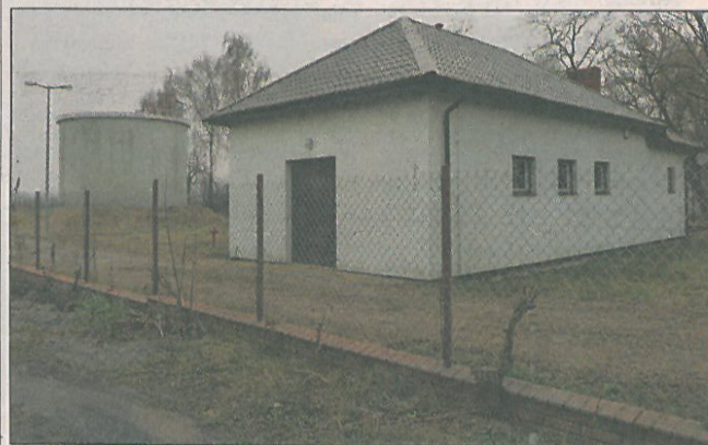
Z ujęcia wody w Orłowie popłynie czysta woda
