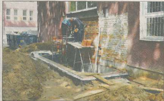
Przy ZSO im. Chopina są wykonywane dodatkowe wejścia
