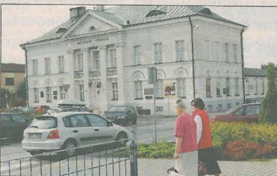
Muzeum wygląda efektywnie. Ale mało kto wie, że stoi na bardzo miękkich fundamentach
