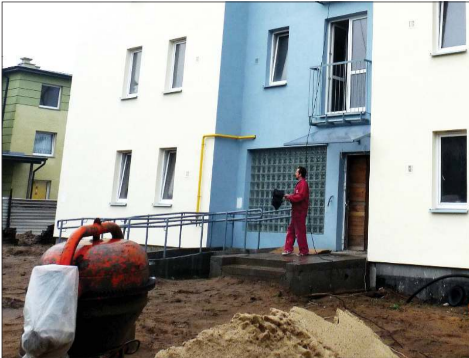
Nowo budowany dom przy ulicy Fabrycznej
