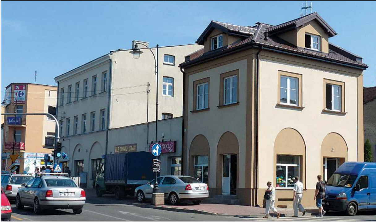
Okazuje się, że nawet bez żadnych nakazów ze strony władz, można zadbać o to, by nasz budynek nie straszyl, a przeciwnie, wyróżniał się architektonicznie, tworząc miły dla oka fragment miasta. (b)
