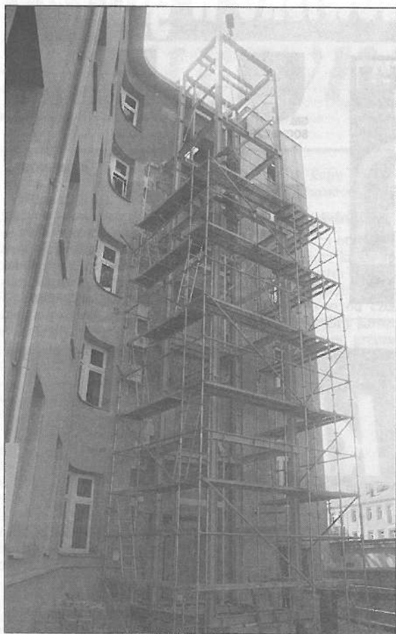
Już niedługo petenci Urzędu Miasta nie będą musieli wdrapywać się po schodach na najwyższe kondygnacje. Pojadą windą.
