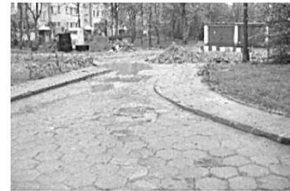
WJAZD PRZED MODERNIZACJĄ
