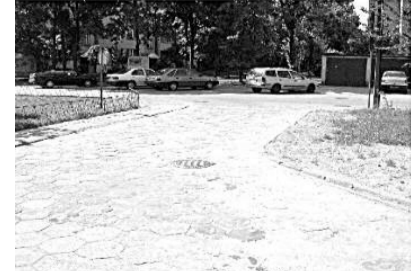
WJAZD PO MODERNIZACJI
