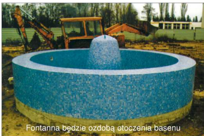
Urządzenia pod dnem basenu już prawie gotowe
