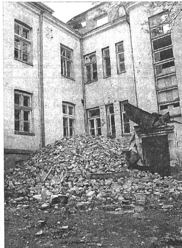
Rozpoczął się remont przyszłego hospicjum w Sochaczewie
