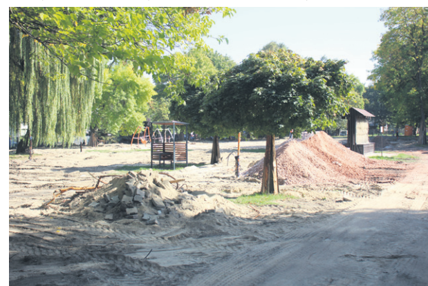
Powstający na terenie ogródka jordanowskiego przy al. 600-lecia nowoczesny plac zabaw - Kraina Przygód póki co jest dużym placem budowy
