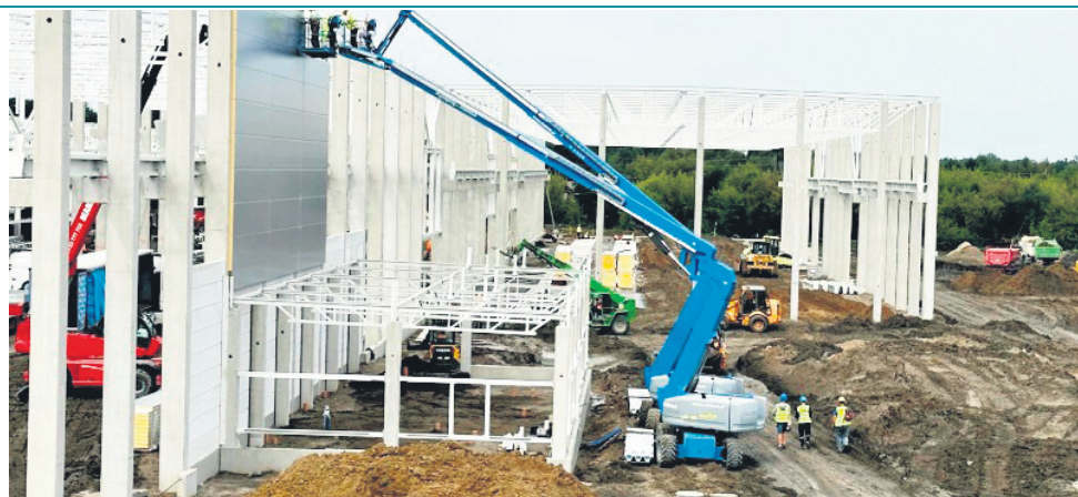
W budowę nowej fabryki w Boryszewie MFO zainwestowała około 130 mln zł
