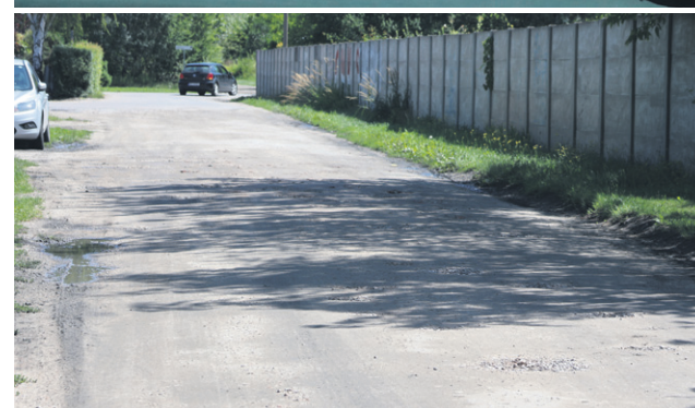
Ulica Krzywoustego na krótko przed przebudową
