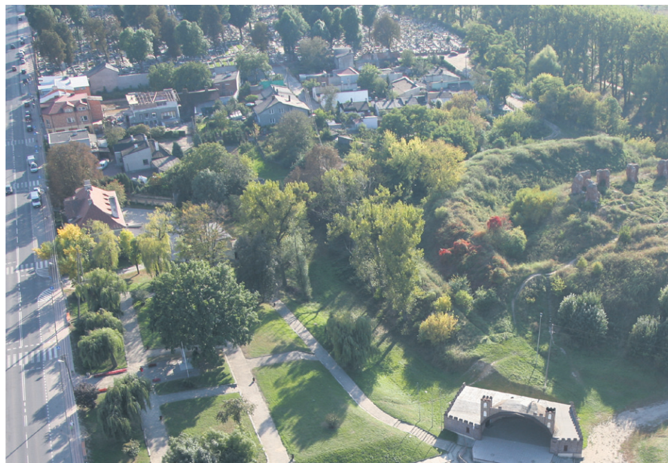
Na zdjęciu z 2009 roku, przed rewitalizacją wzgórza zamkowego, widoczne są wały obronne zamku. Dzisiaj już ich nie zobaczymy. Po lewej stronie widoczne osiedle Kiercelak.
