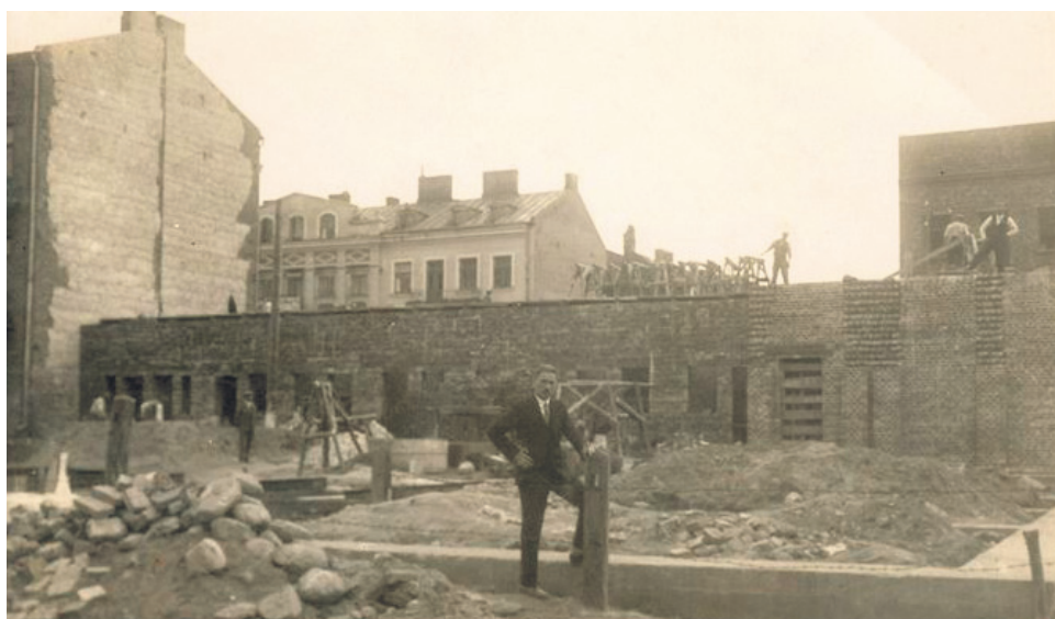
Tadeusz Kobek na tle budowanego domu, jednego z wielu projektów prowadzonych przez jego firmę
