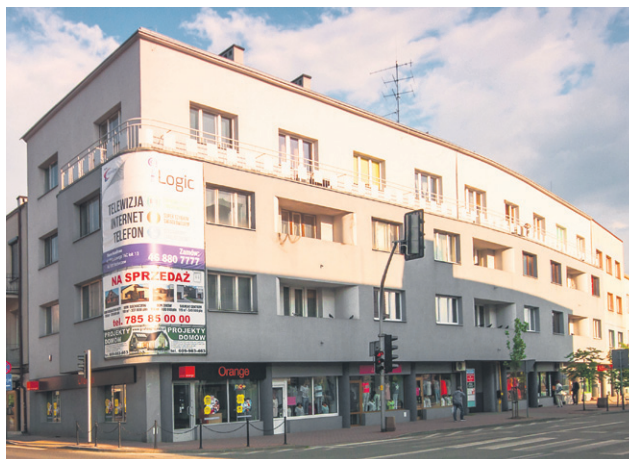
2014 r. Dom Kobka tuż po remoncie, z nową elewacją. (foto archiwum Ziemi Sochaczewskiej)
