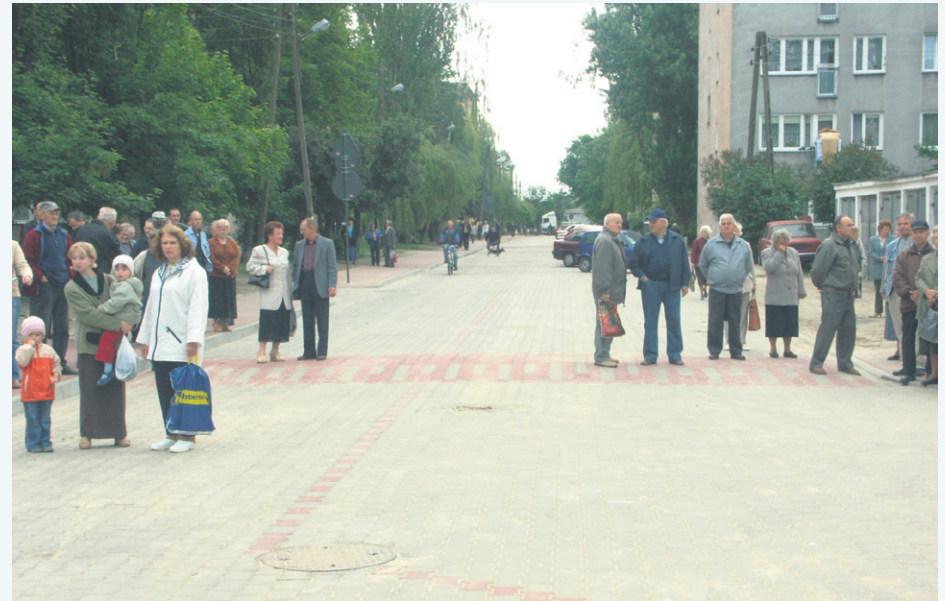
Przebudowa 280 metrów ulicy Senatorskiej kosztowała 475 tys. Prace wykonano w 2005 roku. Zniszczoną trylinkę zastąpiła kostka, wymieniono też nawierzchnię chodników
