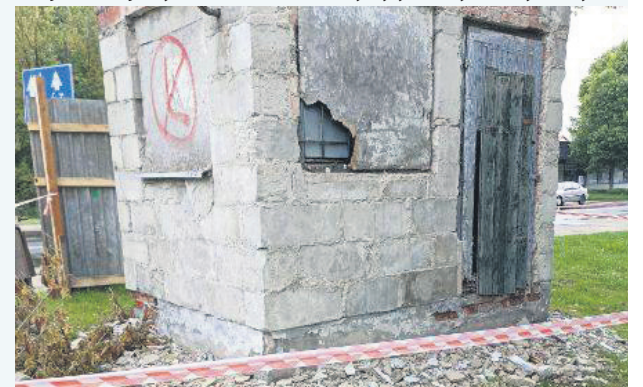
Stan przed remontem
