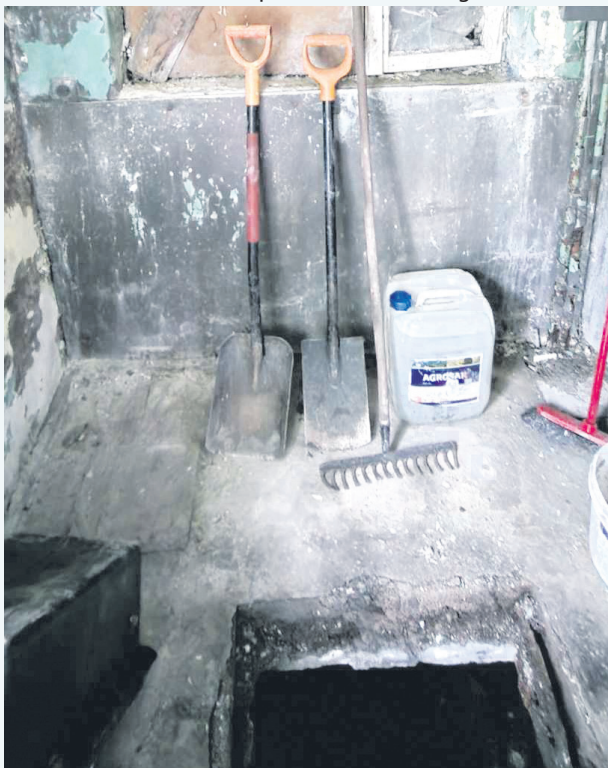
Wnętrze przed remontem. Na pierwszym planie zejście do piwnicy
