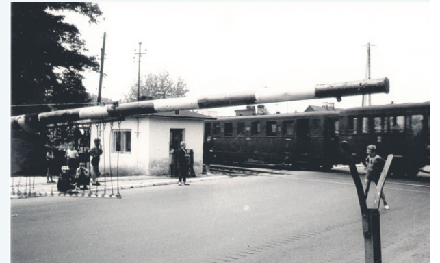
Starszy domek dróżnika był większy, zbudowany prawdopodobnie z cegły, z wejściem od strony ulicy Warszawskiej
